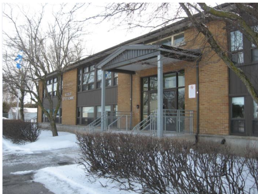
Figure 4 L'école St-Étienne située au 426, rue de l'Église
